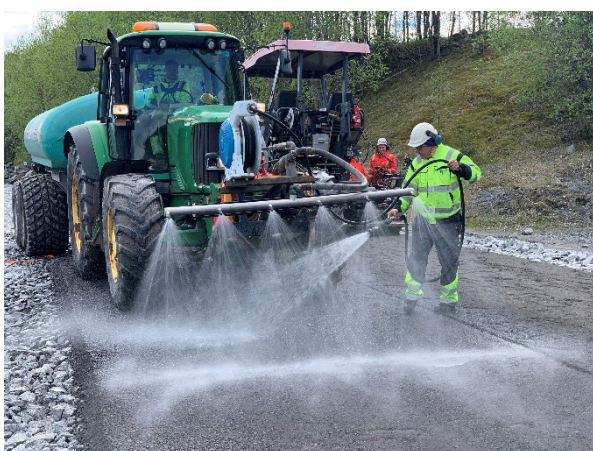
Bilde 4.18 vanning av knust asfalt og 4.19 komprimering av knust asfalt
