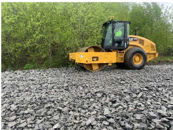
Bilde 4.7 og 4.8 Komprimering av kultlag
