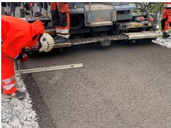
Bilde 4.16 og 4.17. Utlegging av knust asfalt. Denne inneholdt ikke klumper.
