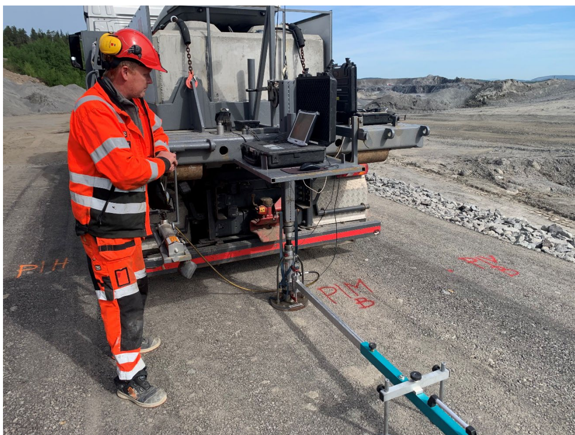
Bilde 5.3 Platebelastning av forkilingsmasse
