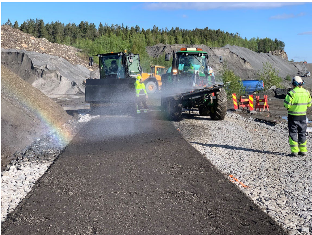
Bilde 4.14. Vanning av fresemassen før komprimering.
