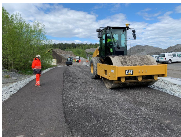
Bilde 4.18 vanning av knust asfalt og 4.19 komprimering av knust asfalt
