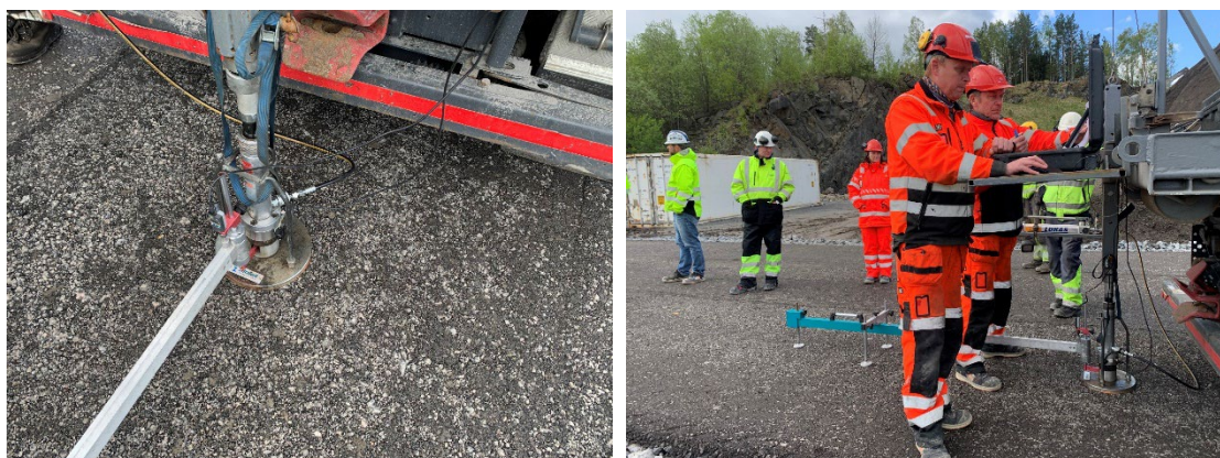
Bilde 5.1 og 5.2 Platebelastning av forkilingsmasse
