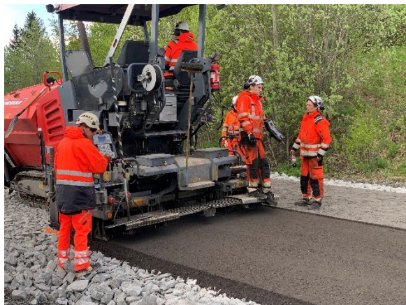
Bilde 4.16 og 4.17. Utlegging av knust asfalt. Denne inneholdt ikke klumper.
