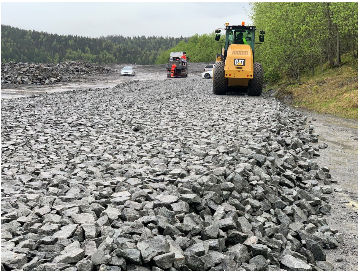
Bilde 4.9 Kultlaget ble kompaktert med CAT CS66B anleggsvals. Linjelast 34,5 kg/cm.
