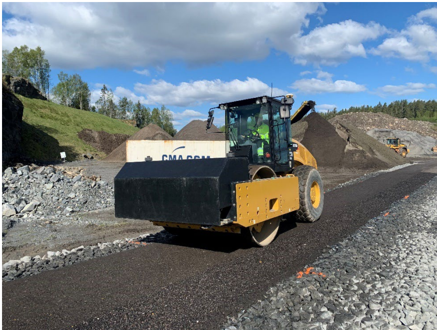
Bilde 4.15. Komprimering av fresemassen
