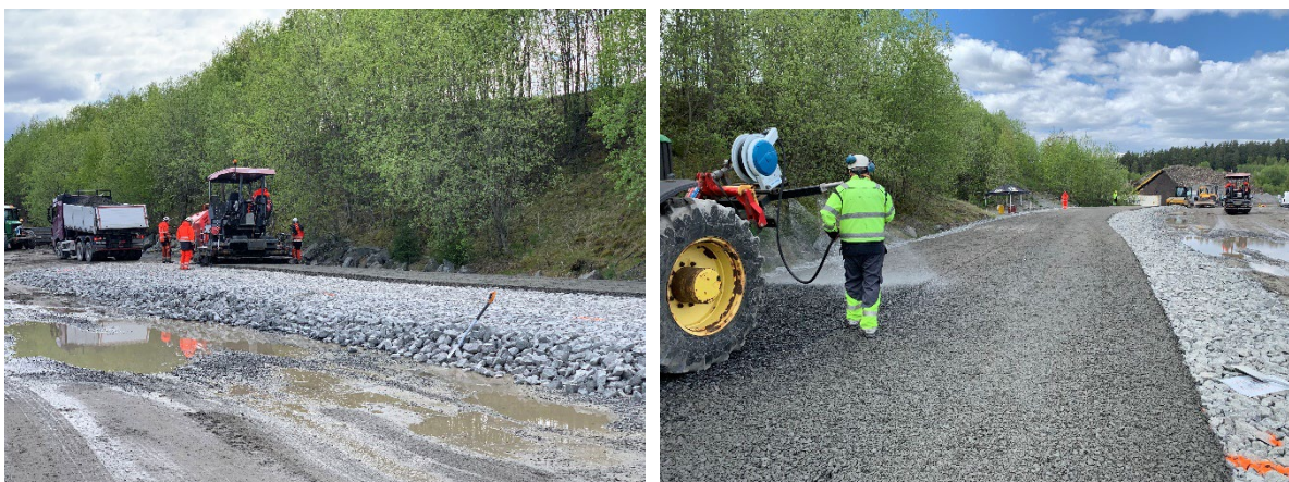
Bilde 4.21 Utlegging og 4.22 vanning av 0/32-masse.
