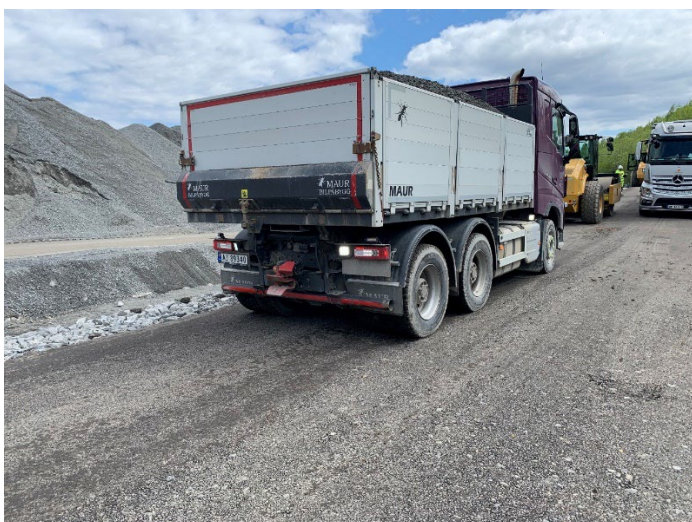
Bilde 4.20. Lastebil ble benyttet til etterkomprimering.
