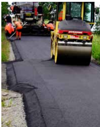
Varme asfaltmasser tilsatt gjenbruk.
