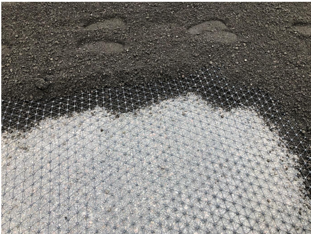
Forsterkning av vei med knust asfalt, Ak.
