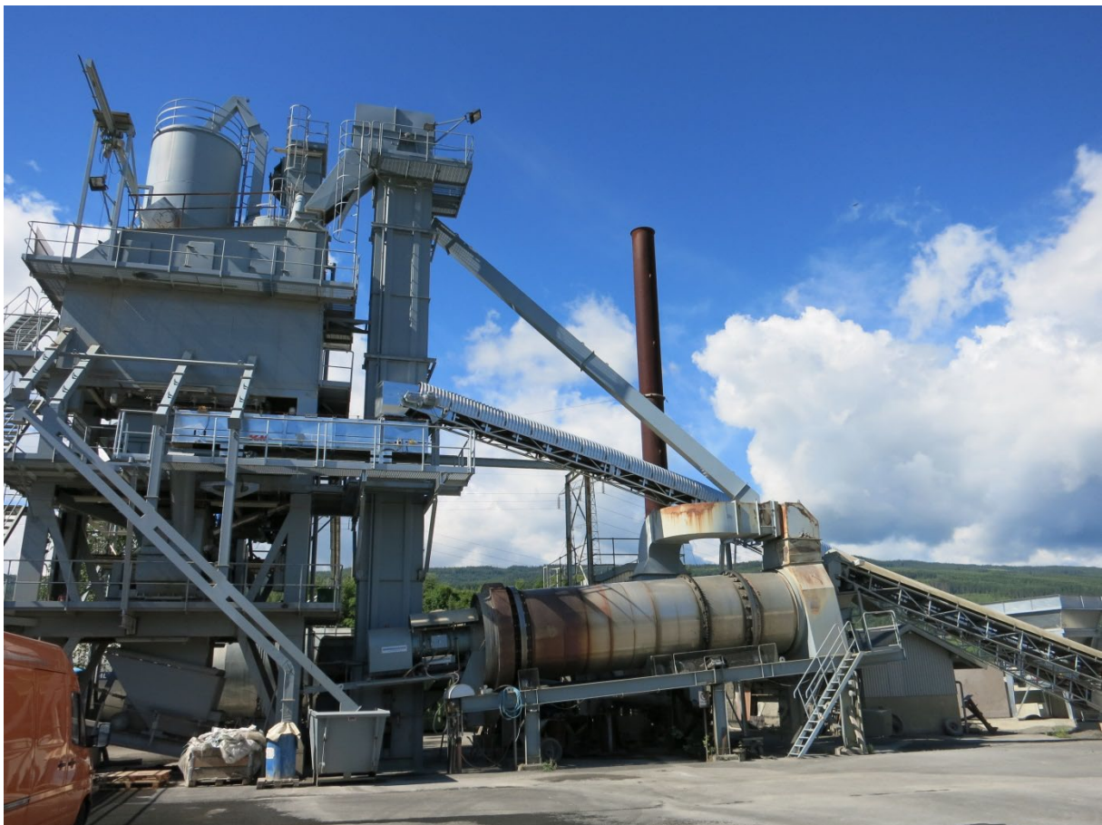
Bilde 9.2 Tilsetning av asfaltgranulat i miksekammeret
