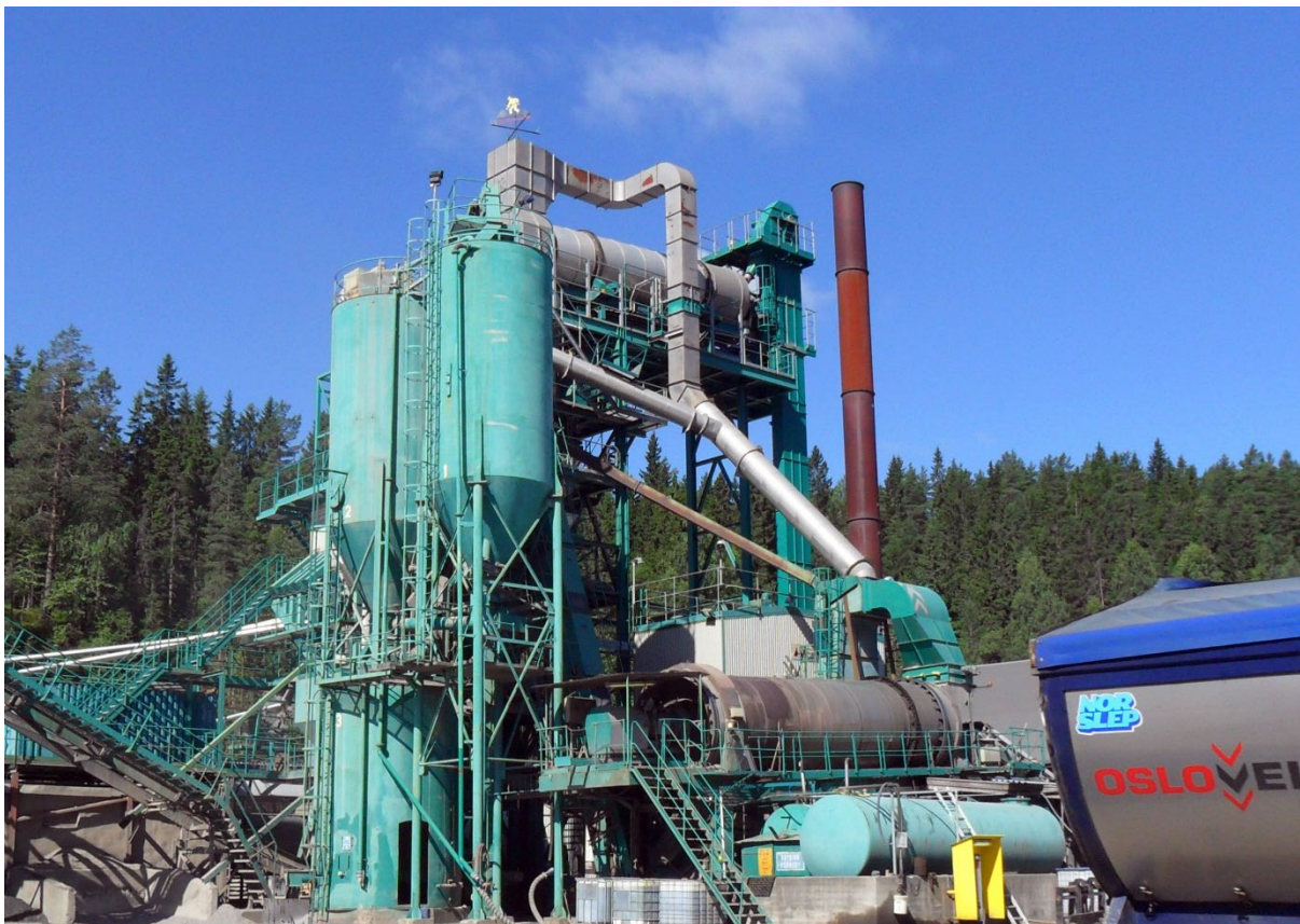
Bilde 9.3 Asfaltfabrikk med egen gjenbrukstrommel
