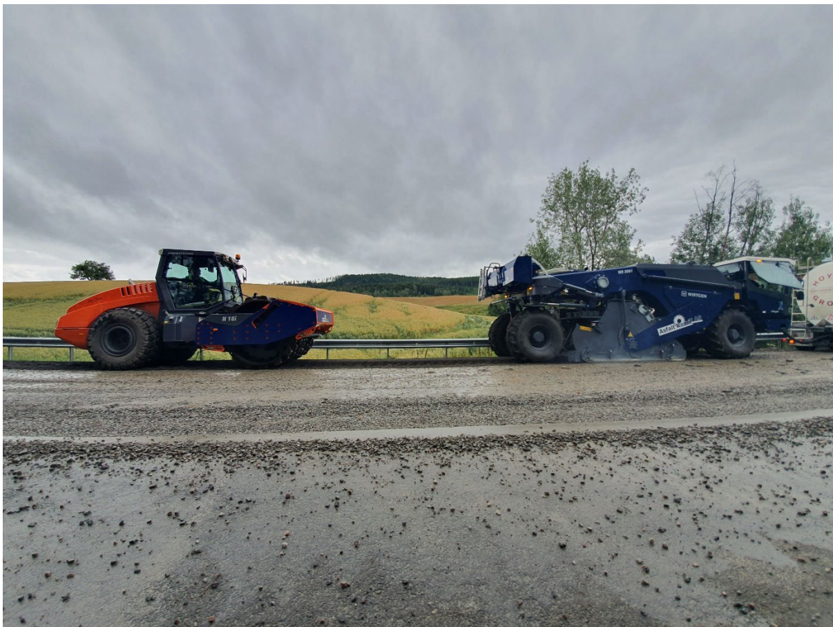
Bilde 11.4. Fresestabilisering av bærelag på lavtrafikkert vei
